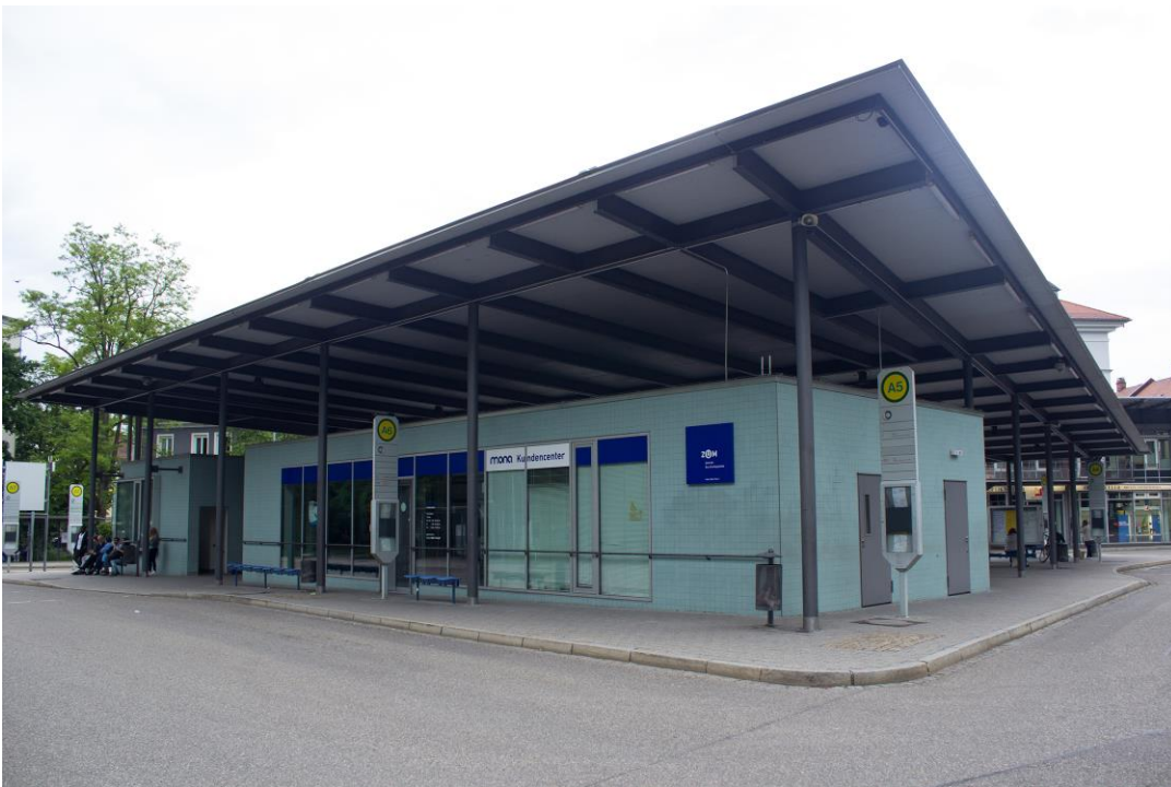
Das neue Design der ZUM nach der Beklebung.
