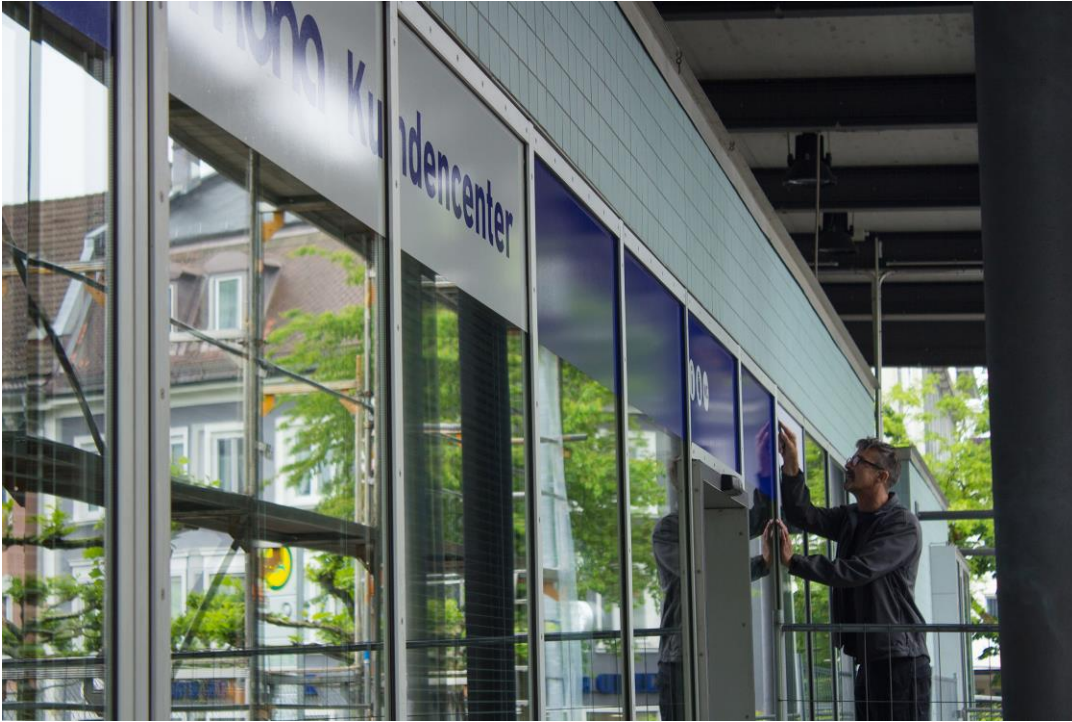
Beklebung der Fenster der Zentralen Busumsteigestelle in Kempten
